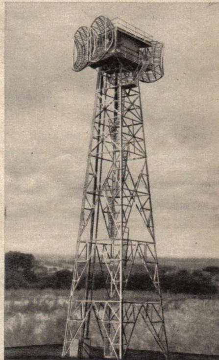
Relaisstation der Dezimeterstrecke im Endausbau für gleichzeitigen Betrieb in beiden Richtungen
