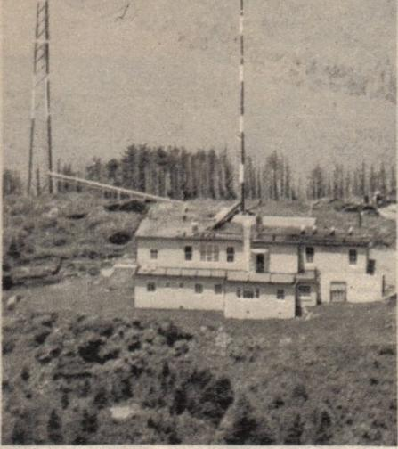
Senderhaus auf dem Clingman's Peak; links im Foto neue 8-fach-Antenne, in der Mitte alte 4-fach-Antenne
